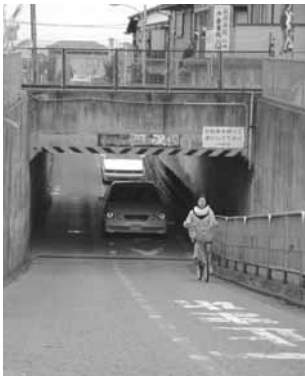
着工がもたれる垣見隧道
