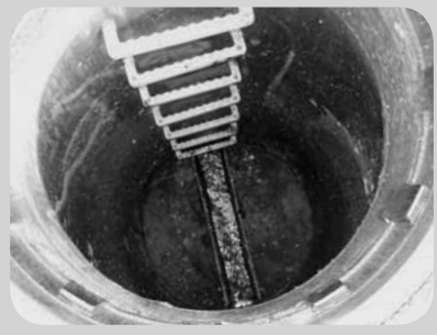
▲正常な状態の下水マンホールの中
