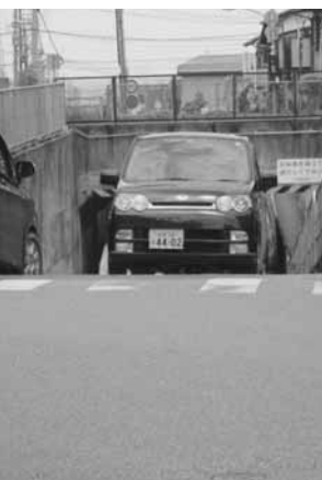
改修に向けて動きだした、垣見隧道
