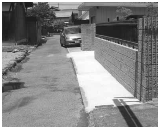
建築基準法の適用がされるブロック塀
