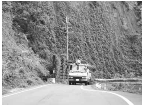
対面通行すらできない国道421号
