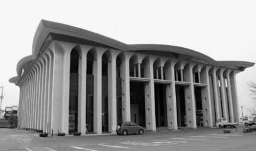
▲ 支所および公民館としての活用が提案された永源寺地域産業振興会館
