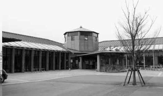
▲ 支所としての活用が提案された愛東保健センター・愛東福祉センター
