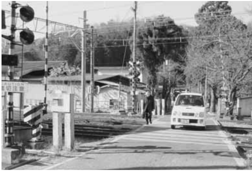
動き出した浜野踏切の改修
