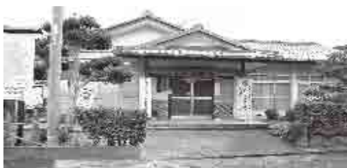
耐震診断を希望されている自治会館
