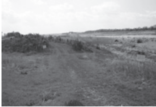
堤防補強が望まれる八千代橋上流の霞堤
