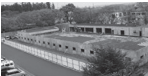
いよいよ始まった本庁舎増築工事
