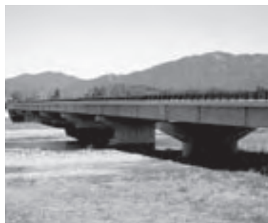
▲建設中の県道湖東八日市線 (愛東町鮎江地先～八日市市中小路地先)
