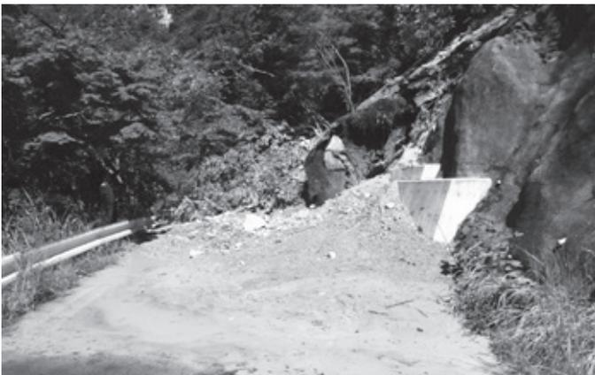
土砂崩れにより寸断された市道
