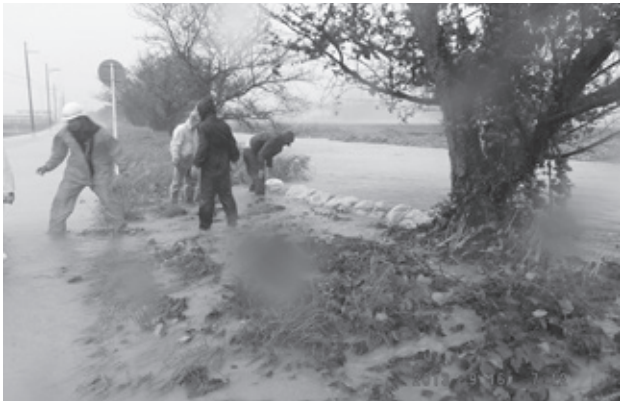
台風18号で尻無町蛇砂川堤防越流 (H25.9.16)
