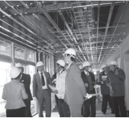
市立八日市野幼稚園・つつじ保育園幼保一体化施設整備工事の現地視察
