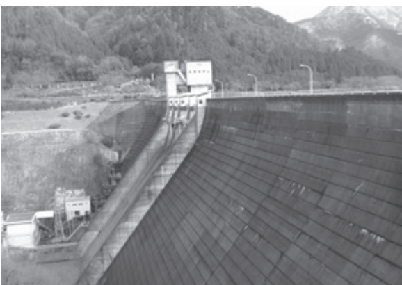
洪水調整機能は期待できない利水ダム（永源寺ダム）
