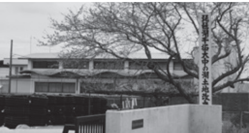
ポンプの老朽が心配な 琵琶湖干拓新田排水機場
