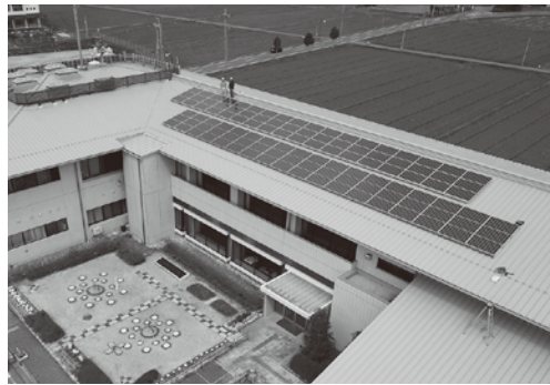
県立平和祈念館の市民共同発電所3号機
