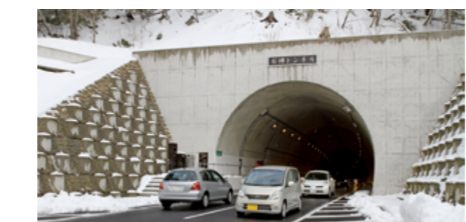
⑨石樽トンネルの開通により中部圏との往来が活発となっています。また、三重県いなべ市と災害時の相互応援の協定を締結するなど、新たな交流が始まっています。
