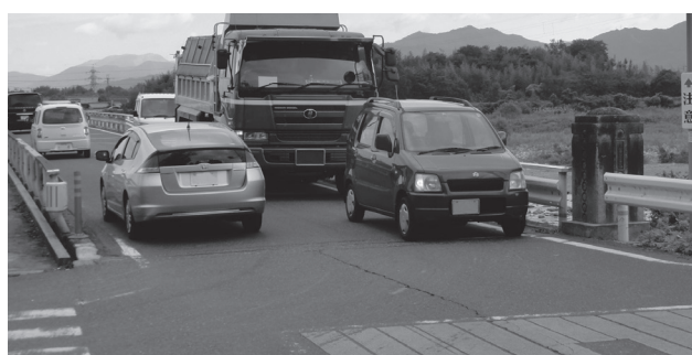
大型車両との離合が困難な御河辺橋
