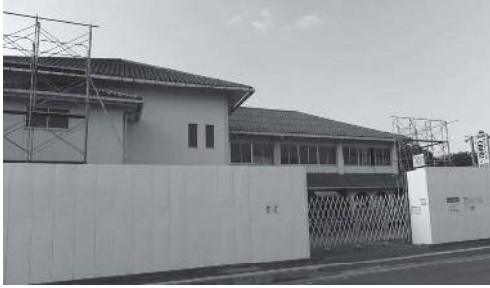
解体が始まった市役所別館
