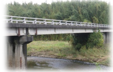
（修繕前の大森橋）
