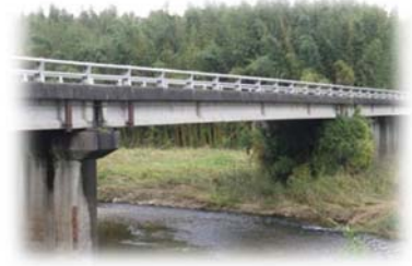
（修繕前の大森橋）
