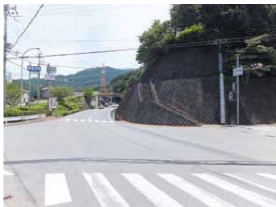
絶え間なく往来するダンプカーで安全が心配される永源寺地先
