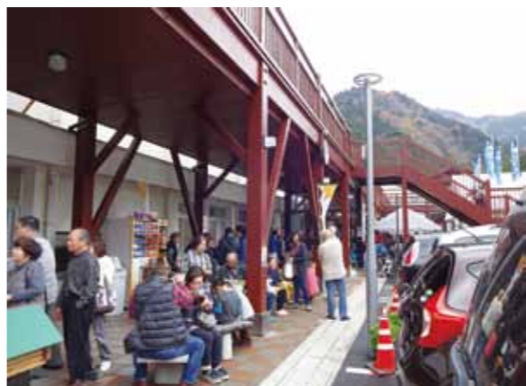
鈴鹿山系を一望できるデッキが完成
