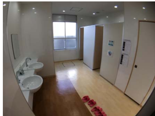
(改修後のトイレ)
