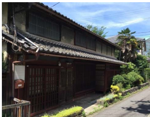
(まちづくりの拠点として改修予定の古民家)
