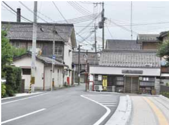
行き詰まり感のある道路 いつ解消
