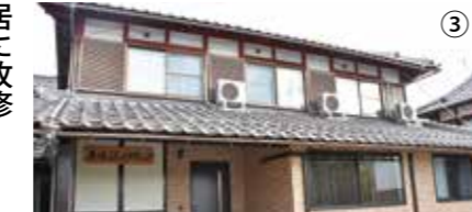
②庭を整備する地域の皆さん ③完成した住居
