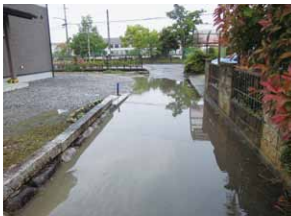
大雨が降ると冠水する里道
