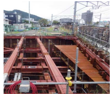
(中学校線工事状況)
