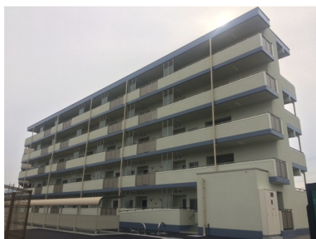
(市営大森団地改築(第一期) H30 完成)
