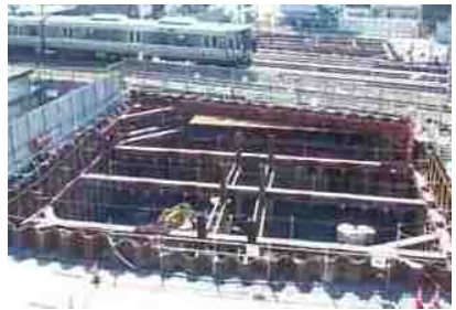
着々と工事が進む垣見隧道
