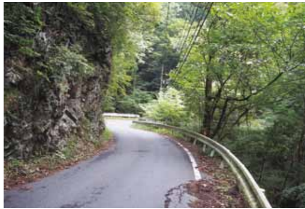
狭くてカーブが連続する多賀永源寺線
