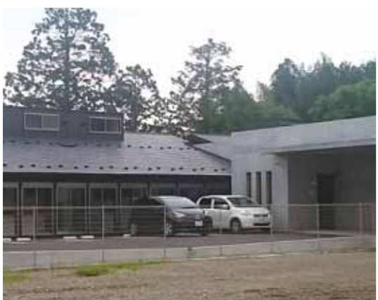
新しく開所された障害者グループホーム
