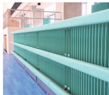
建物に合わせてデザインされた空調設備の本体パネル
