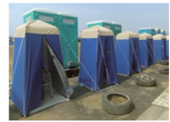
災害時にマンホールをトイレとして使用した一例（し尿は、地中の管を通り、下流の下水道へ流れる仕組み）
