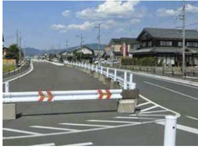
工事が進む外環状線
