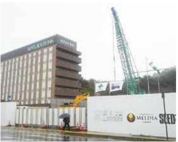
工事が始まった八日市駅前
