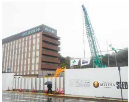
工事が始まった八日市駅前
