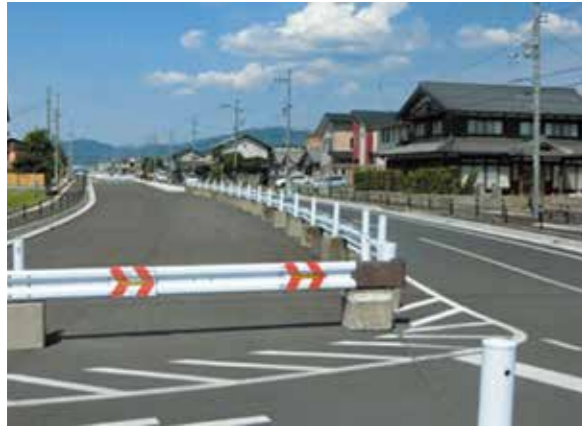
工事が進む外環状線
