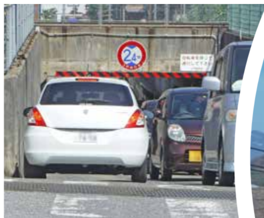
▲車幅が狭く、対向も困難な旧隧道
