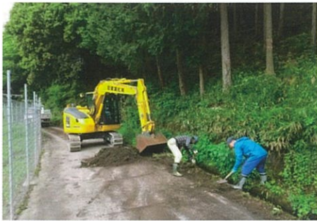
道路側溝の土浚え
