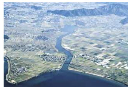
田園地帯の給水は電力頼み
