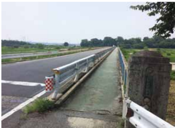
改修が待たれる御河辺橋
