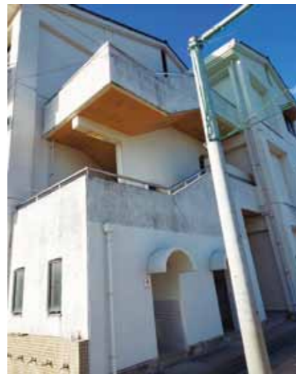
改修が急がれる学童保育所
