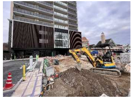
建設中の観光交流施設
