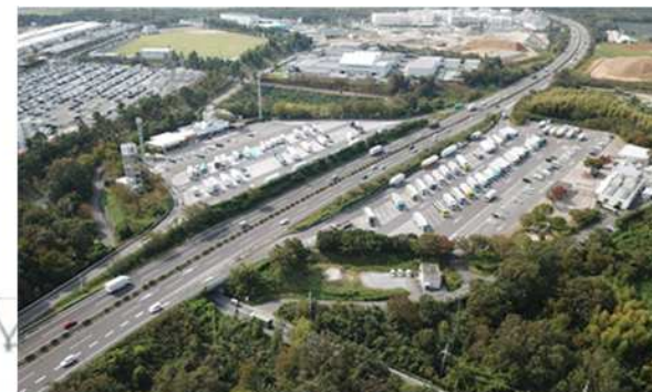
（仮称）黒丸スマートIC設置推進事業
