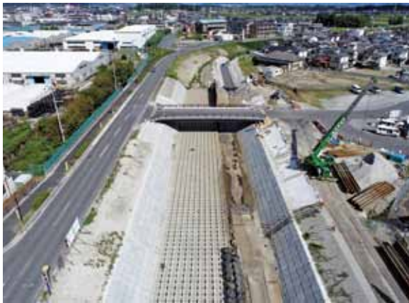
改修が進む八日市新川
