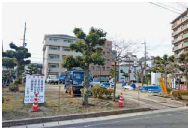
工事が進むまちなか公園
