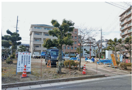
工事が進むまちなか公園
