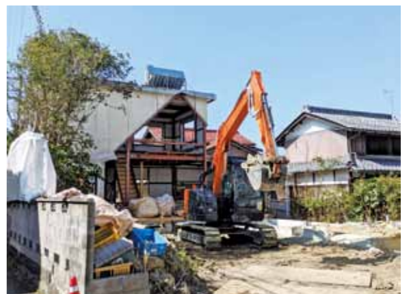
空家を解体して新たな宅地に
