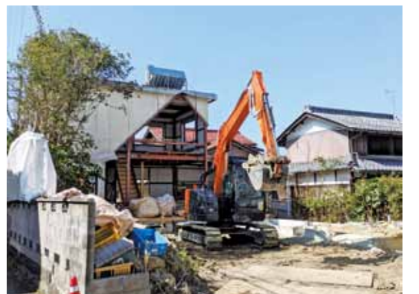
空家を解体して新たな宅地に
