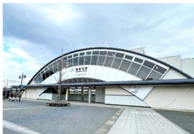
公共交通環境の整備 （JR能登川駅舎の長寿命化）
