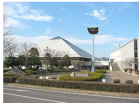
スポーツ施設の機能の充実 (総合運動公園布引体育館大規模改修)
