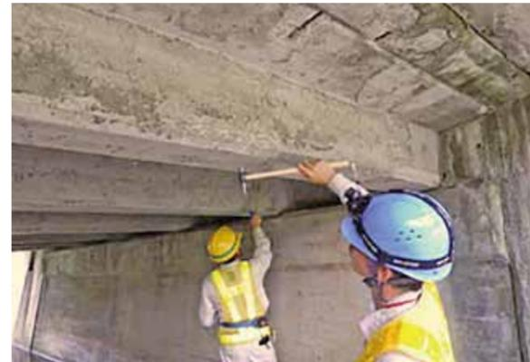
橋梁点検状況（打音・ひび割れ調査）
