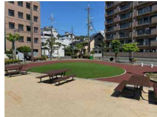
駅前土地区画1号公園の一部に人工芝やベンチを設置するとともに、イベントスペースを整備しました。
