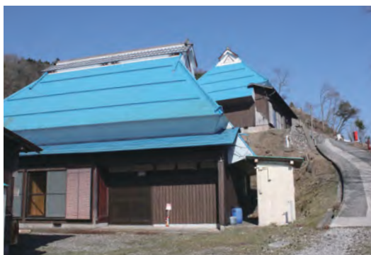
移築古民家群
